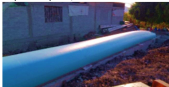
Imagen 2. Biodigestor tipo bolsa
