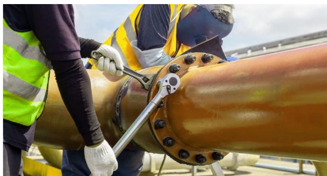
Figura 25: Conexão flangeada com estojo (19)
