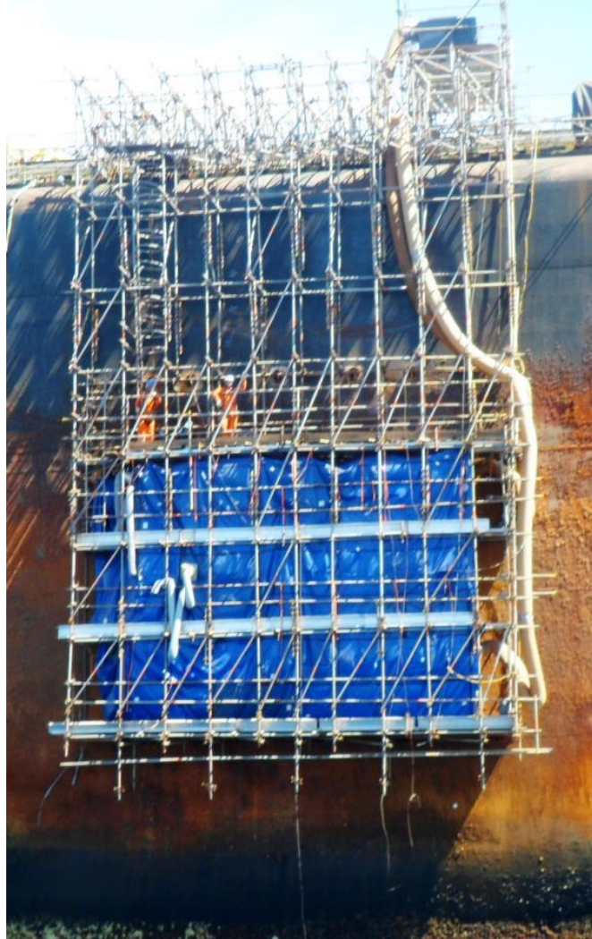
Figura 3: Aplicação de um reparo estrutural com compósito [4].
