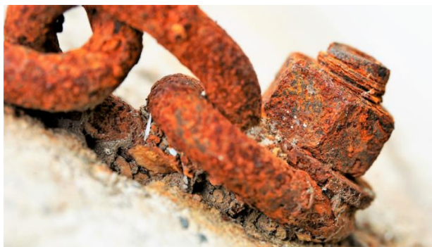
Figura 2 – Corrosão uniforme Fonte: Portal Rizeja
